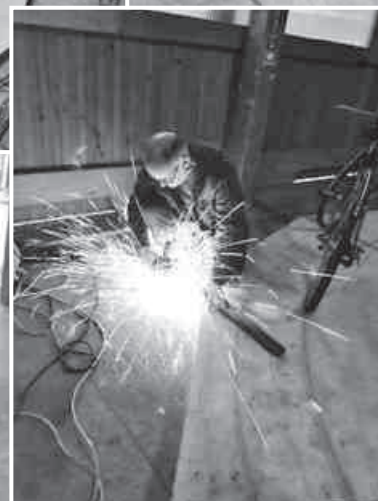
Wo gearbeitet wird, sprühen auch mal Funken
