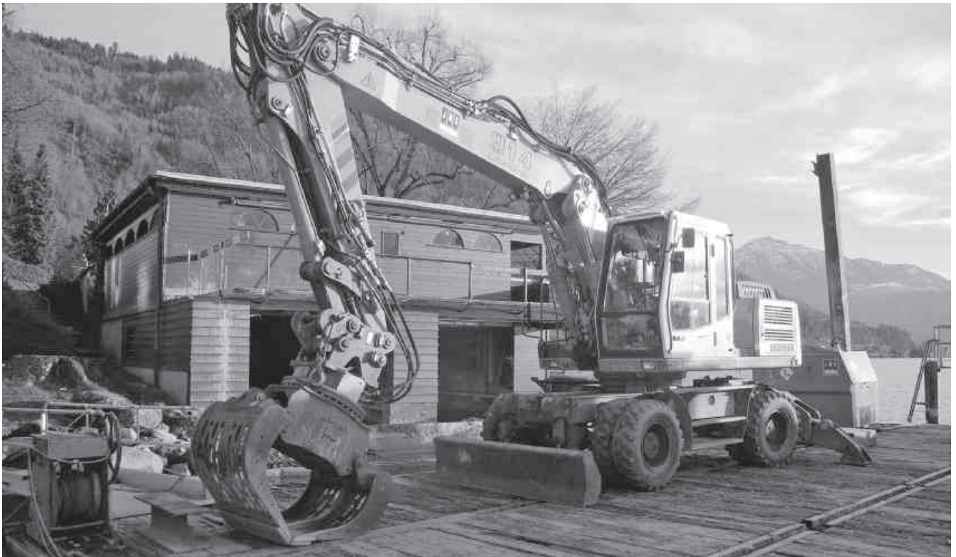
Noch ist die Trubikerbadi mehr ein Bau- als ein Badeplatz; bis im Sommer wird aber alles gut.
