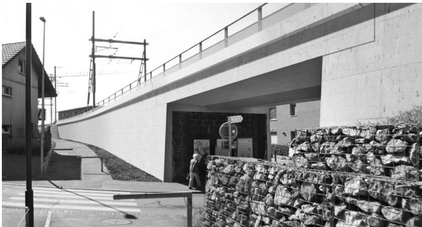
Unterführung und Bachdurchlass Widenstrasse. Neue Brückenplatte aus Stahlbeton, Neuer Fangedamm für Umlegung des Rad-Gehwegs*
