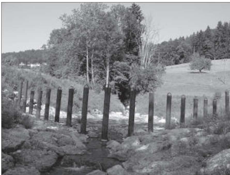
Verbauungen am Brunnenbach
