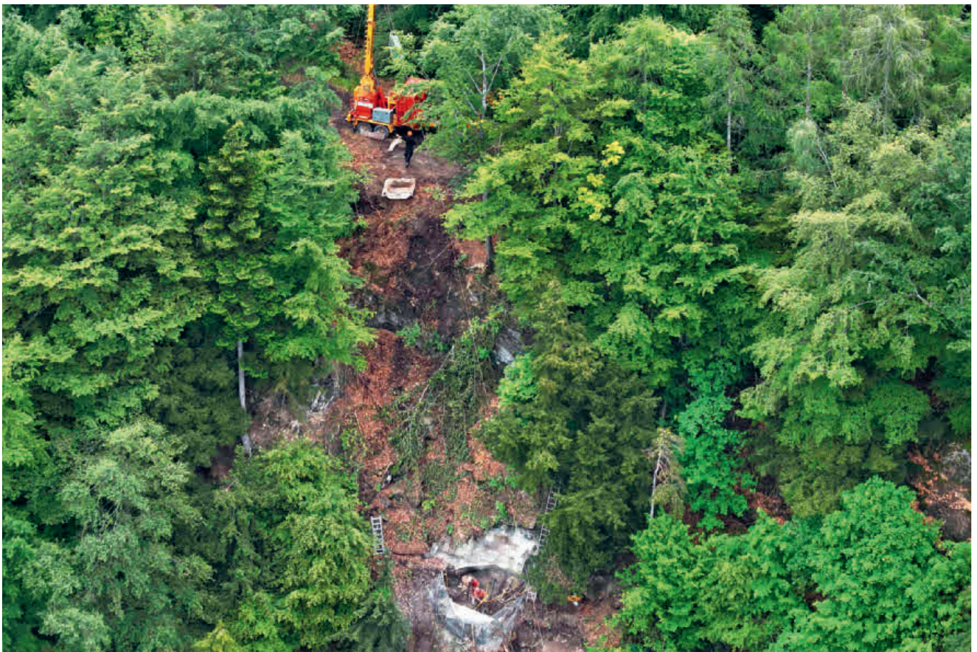
Die Abbruchstelle bei der Nüflue
