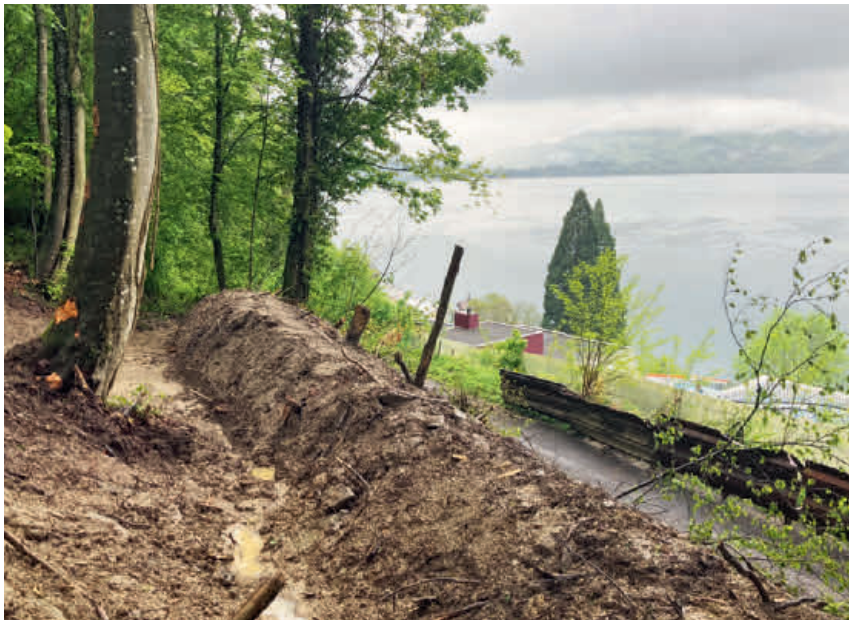
Der Rückhaltewall mit den Palisaden
